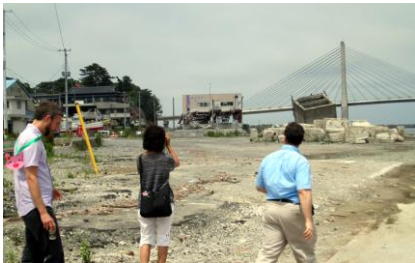
Observação dos danos do tsunami no Porto Pesqueiro de Haragama
